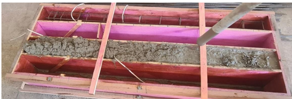
Figura 3.12 - Concretagem das vigas VCC1 e VCC2.
