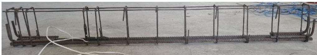
Figura 3.9 - Armação das vigas VCC1 e VCG1.
