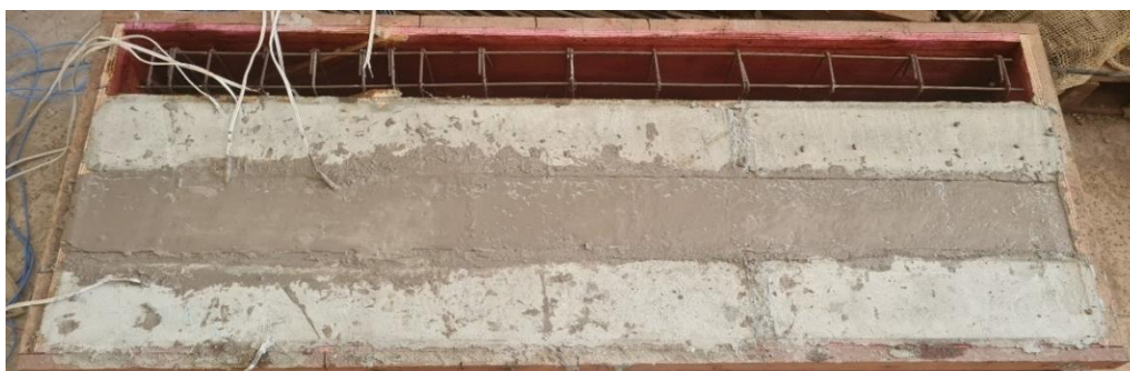
Figura 3.14 - Concretagem das vigas V_{CG1} e V_{CG2} .
